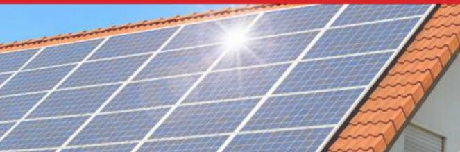
Las **instalaciones fotovoltaicas coplanares** aprovechan el grado de inclinación del tejado o cubierta. Sobre el mismo se fijan los soportes para conseguir que el proceso de colocación sea más rápido y sencillo, así como un menor impacto visual y una disposición de paneles más regular.
